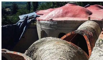
Figura 7. Construcción de techos abovedados sobre pared de adobe "enuhacalado" | Fuente: "Debarro Arquitectura"
