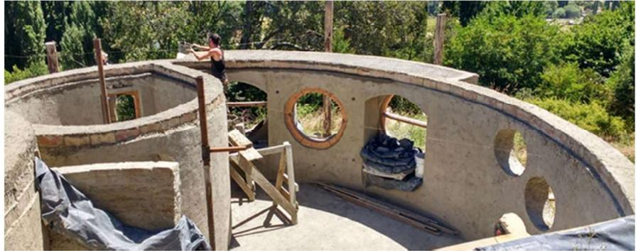
Figura 5. Construcción de paredes curvas con técnica de adobe "enuhacalado" | Fuente: "Debarro Arquitectura"
