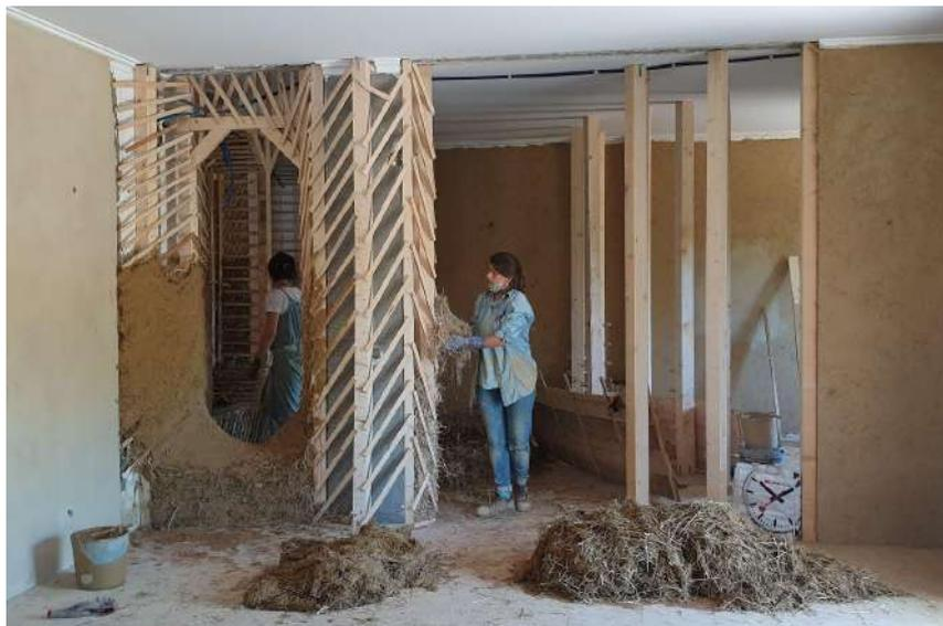
**Foto 8 .Fotos del proceso de llenado de paredes.**
