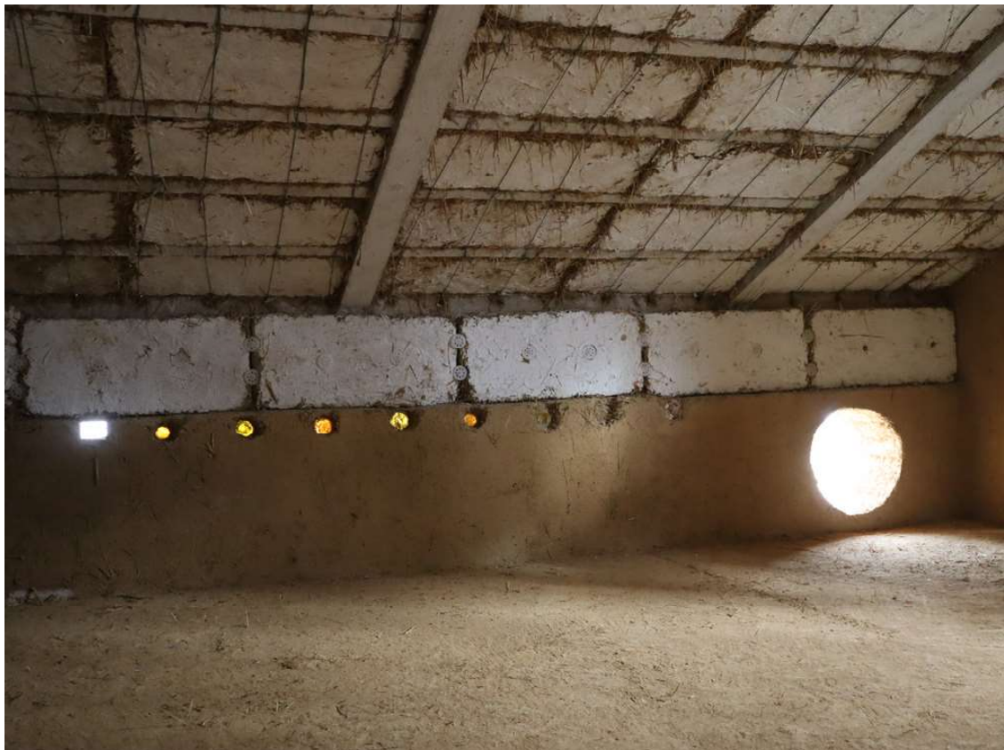
Figura 5. Pared y techo revestidos con placas aislantes de arcilla/paja. Etapa de obra en ejecución
