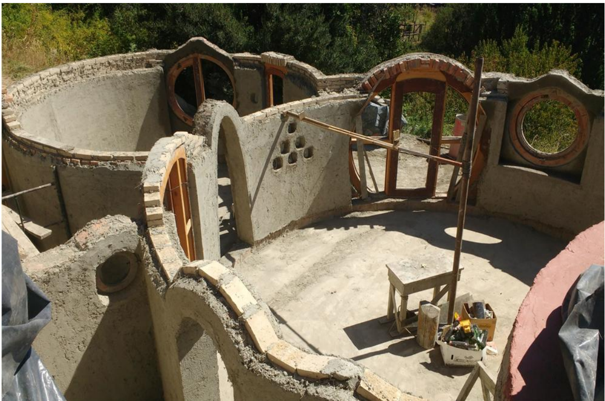
Figura 3. Construcción de pared de “traba hueca” con un compás para determinar la geometría de la planta arquitectónica (crédito: M. Aresta)
