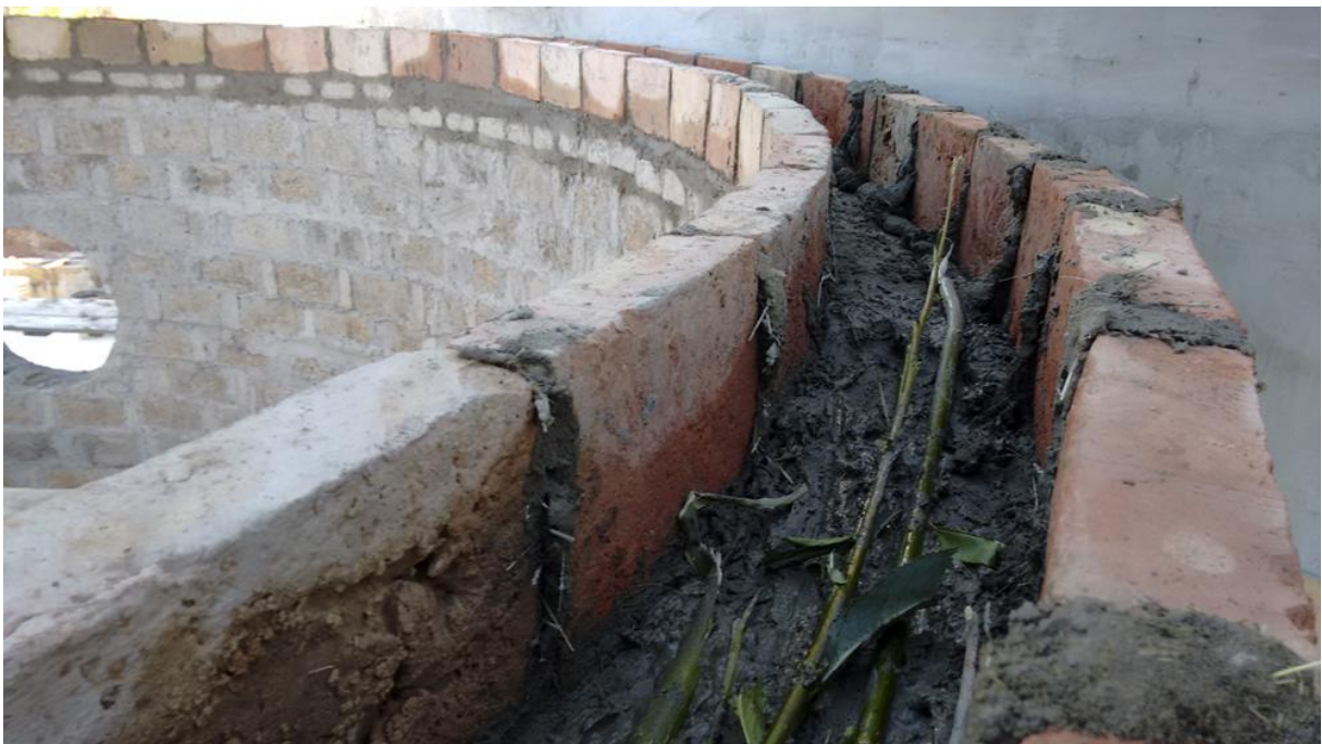
Figura 4. Construcción de un encadenado de sauce y barro con encofrado perdido de ladrillos (crédito: M. Aresta)
