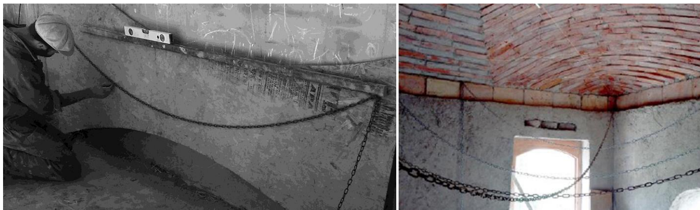
Fig. 1(izquierda). Cadena colgada que define el arco funicular de fuerzas.
