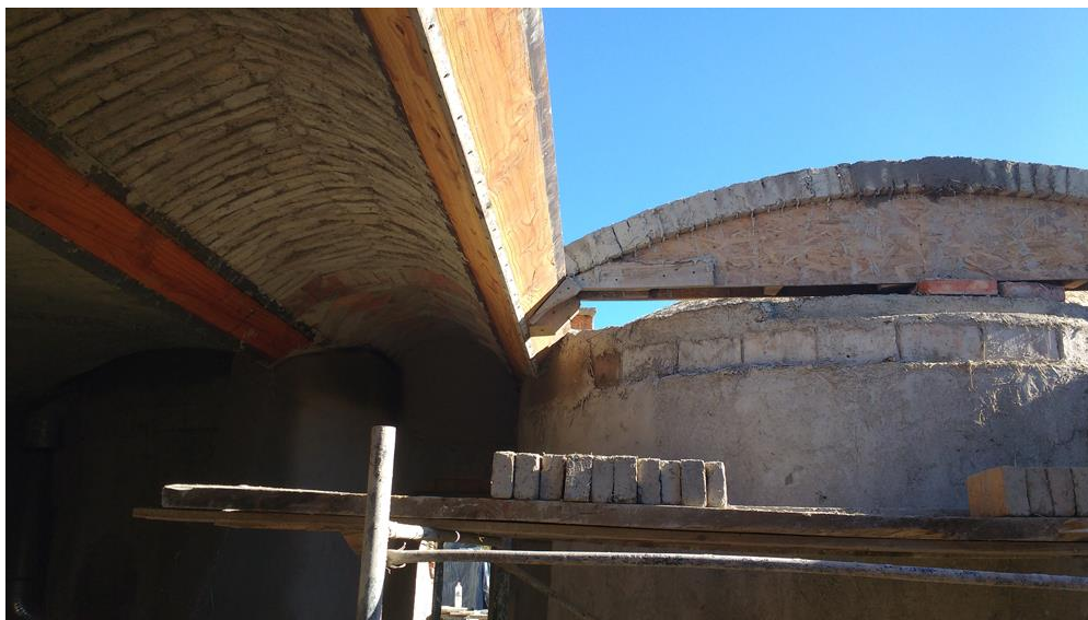
Fig. 4. Construcción de una bóveda de forma orgánica teniendo como referencia el arco tímpano de catenaria
